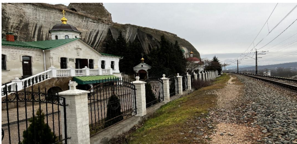
Рис. 2. - Инкерманский монастырь и участок железной дороги, подлежащий перемещению. Фото из архива автора.
