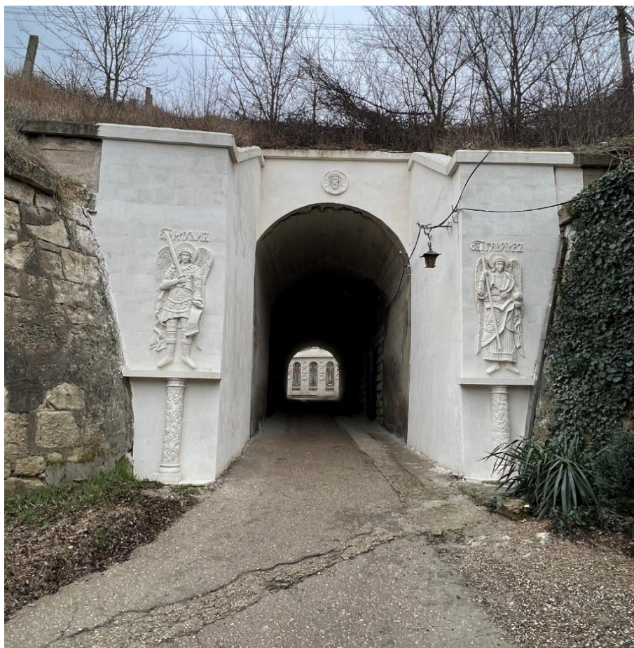
Рис. 4. - Тоннель. Фото из архива автора.
