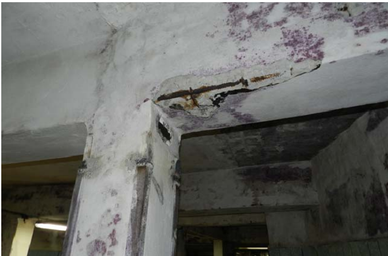
Рис. 2. – Нарушение защитного слоя бетона и сплошная коррозия арматуры
