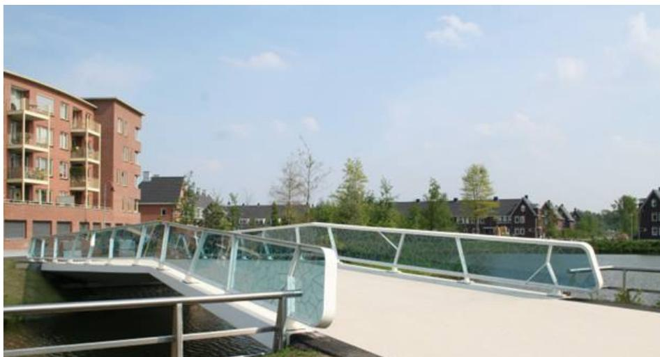
Рис.4 – Монококовый мост с двойной кривизной.
