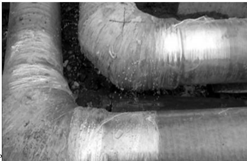
Рис. 1. - Наличие брызг теплоносителя через повреждения в угловых соединениях прямой линии трубы с элементами компенсаторов
