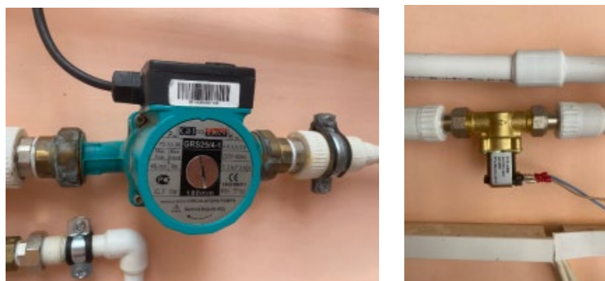
Рис. 4. Поверхностный насос гидравлический GRS 25/4-1 и соленоидный электромагнитный клапан
