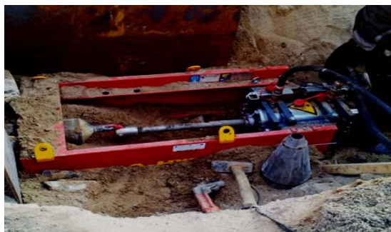
Рис. 3. – Штанговый разрушитель TERRA-HYDROCRACK HC
